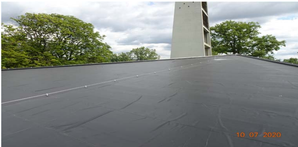
Blick Richtung Norden zum Zeitpunkt der Abnahme der ausgeführten Leistungen.
