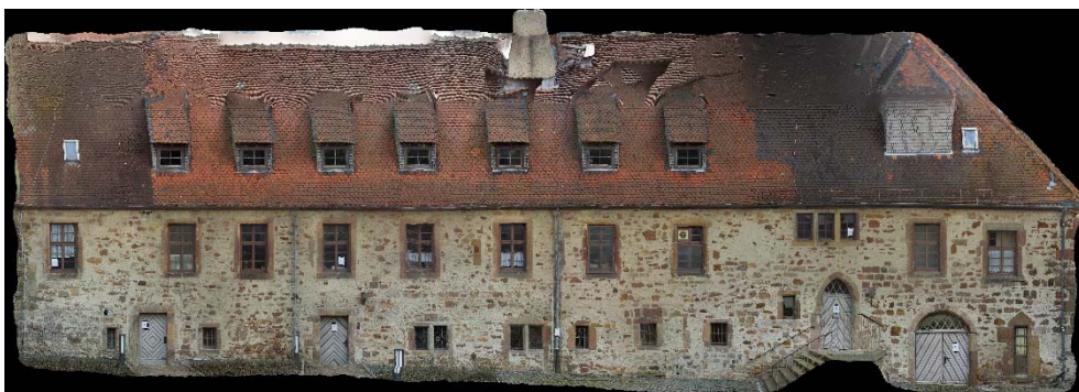
Vorzustand des Stiftsgebäudes, Ost-, Süd- und Westfassade (Aufnahmen Johannes Heep).
