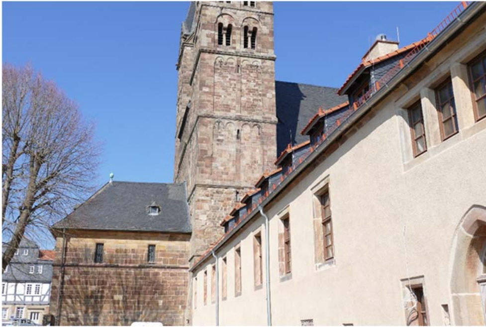
Westfassade des Stiftsgebäudes mit Blick zur Stiftskirche nach der Restaurierung.
