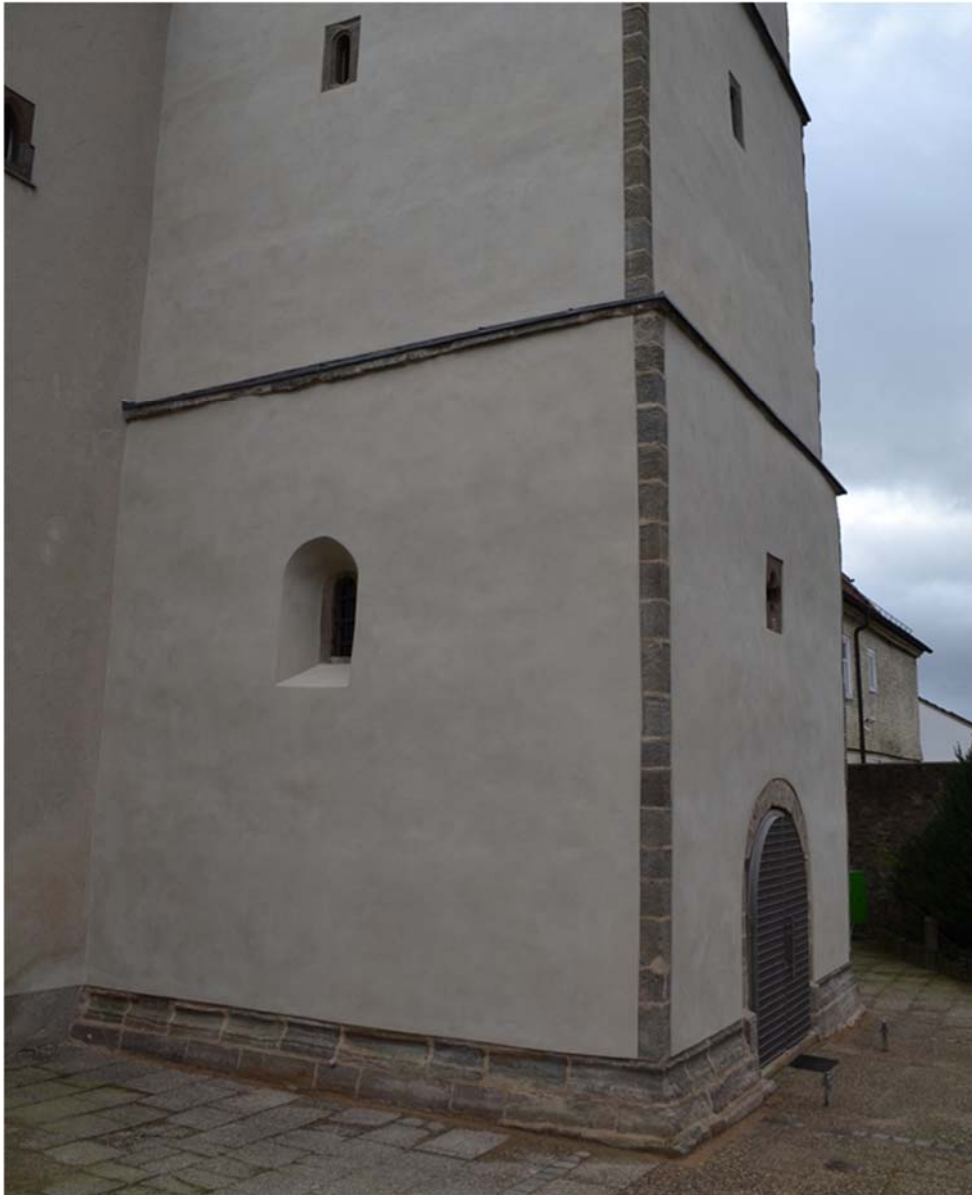
Teilansicht von Nordwesten nach Abschluss der Arbeiten.
