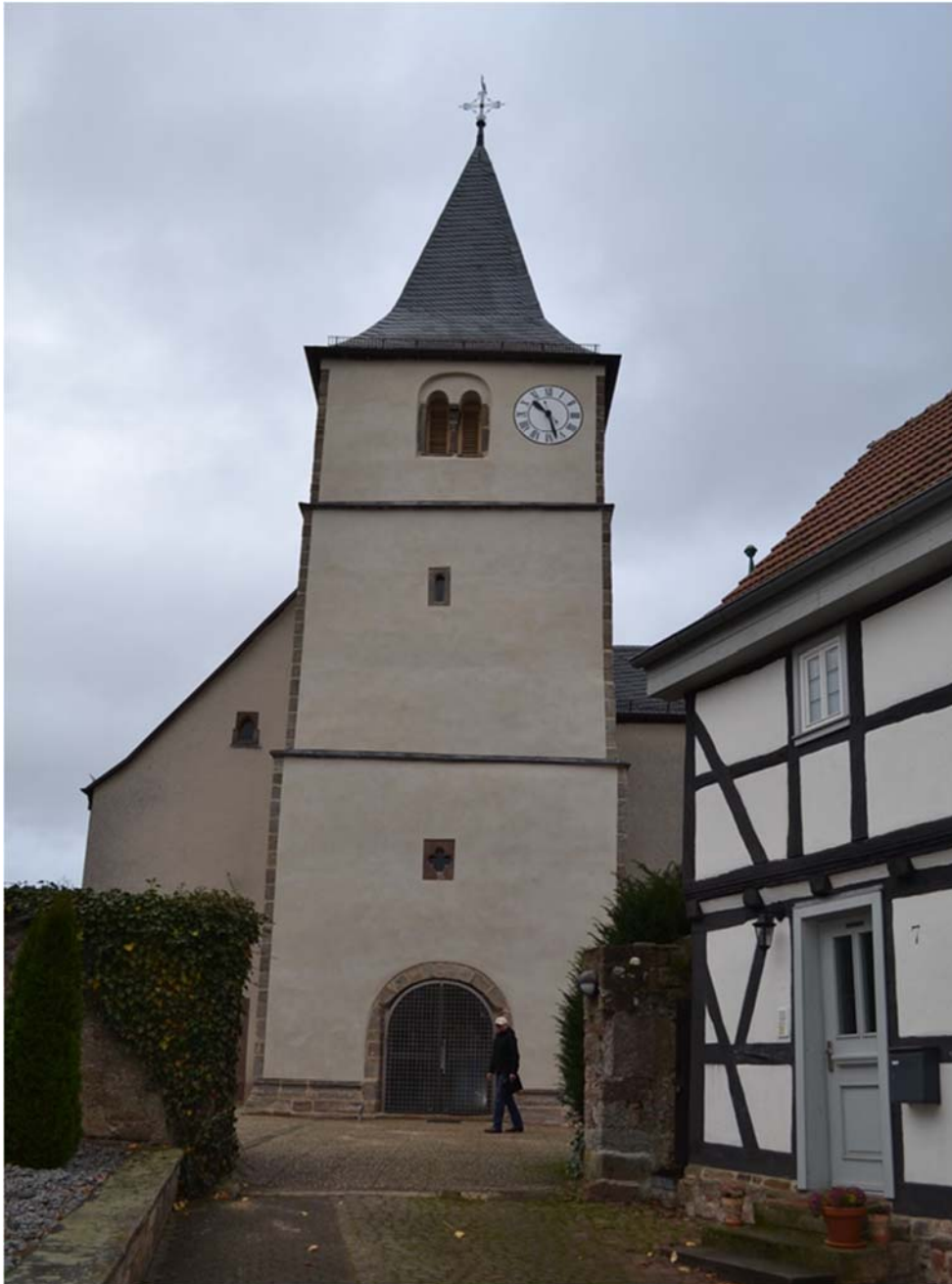
Gesamtaufnahme von Westen nach Abschluss der Arbeiten (Aufnahme Harald Mathes).
