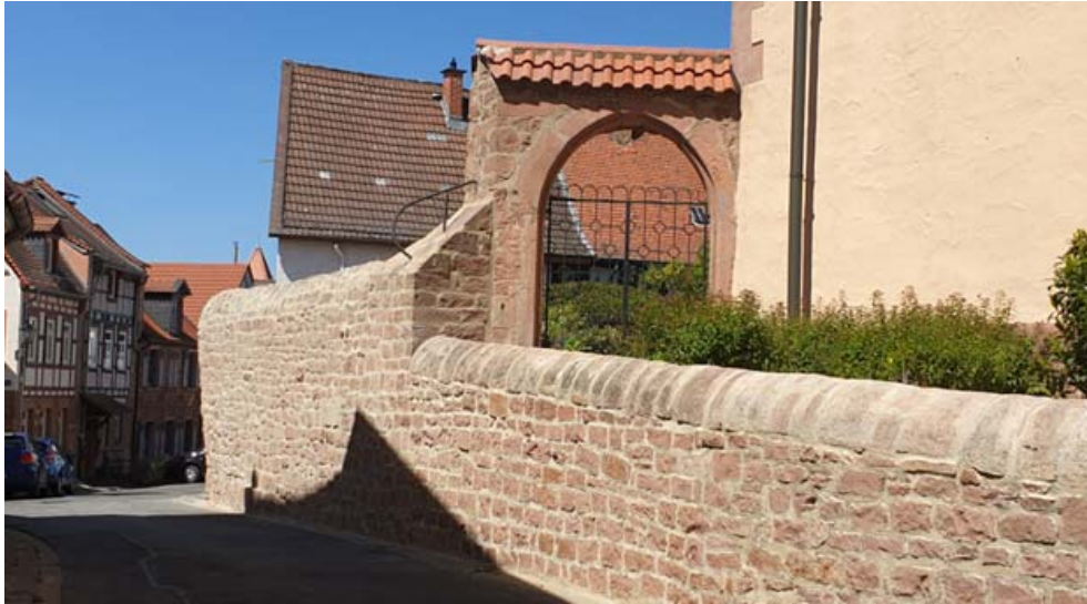
Ansicht der Mauer nach der Instandsetzung.
