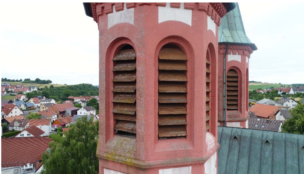
Achteckiger Turmaufsatz mit verwitterten Schallluken.
