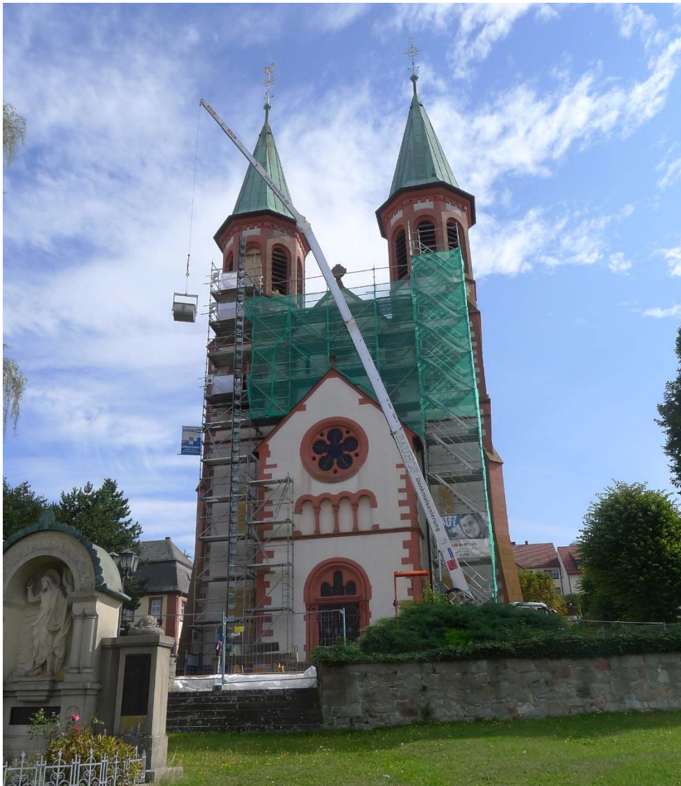
St. Georg, Hofbieber, Westfassade während der Arbeiten.
