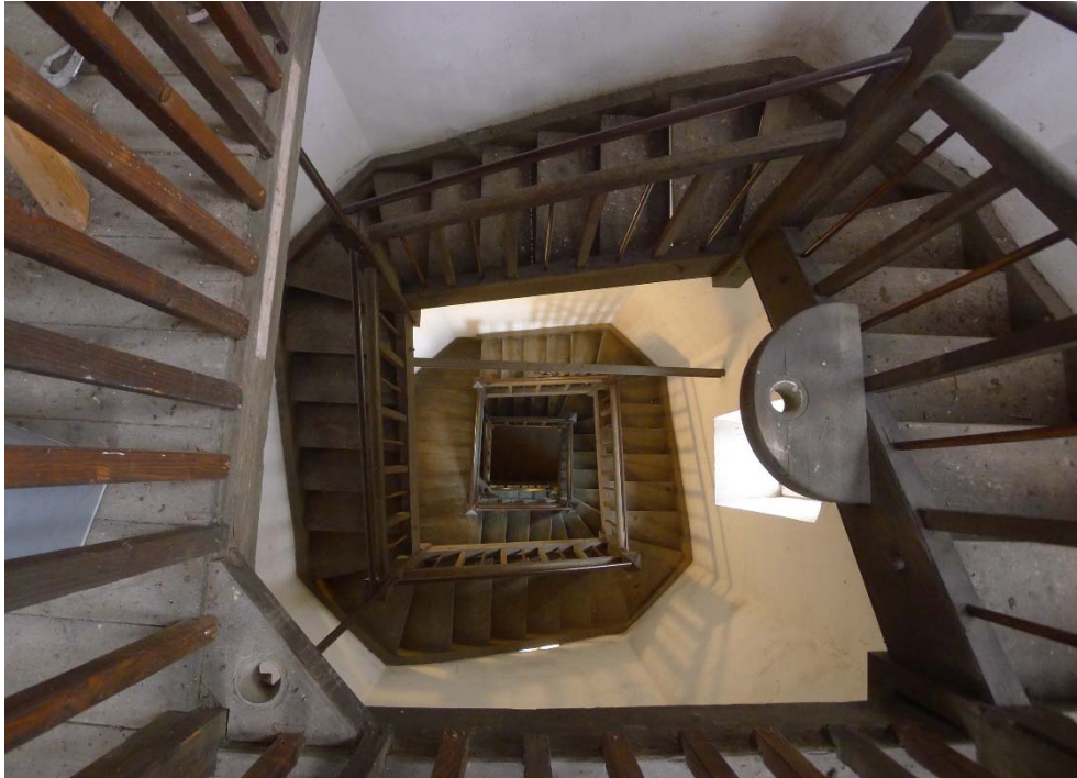
Bauzeitliche Treppe im Südturm.
