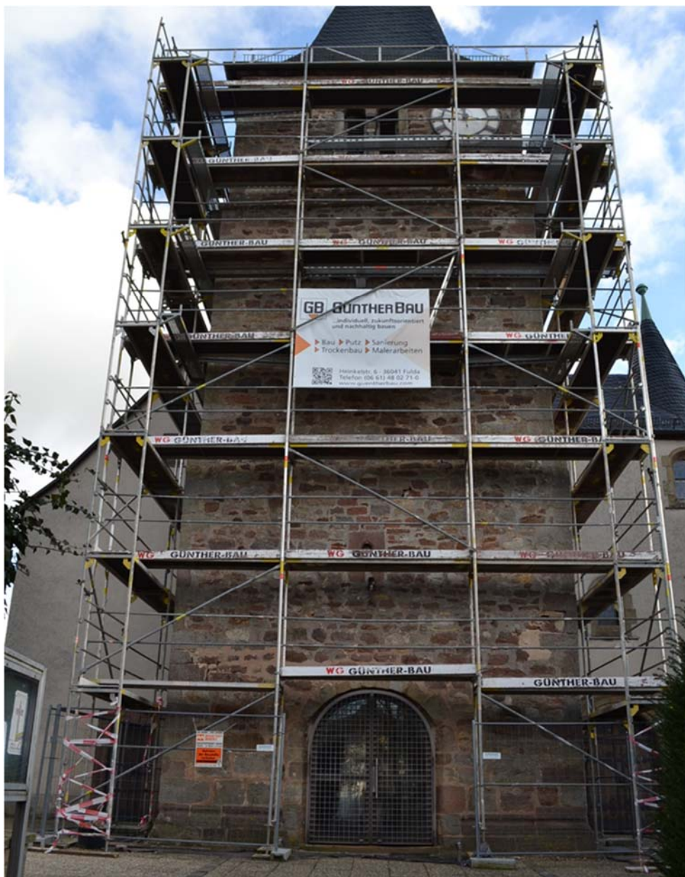
Gesamtaufnahme der Westfassade vor Beginn der Arbeiten.
