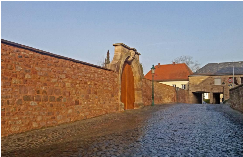
Blick durch die Hinterburg nach Norden, im Hintergrund das Hinterburger Torgebäude; nach Abschluss der Mauerrestaurierung.
