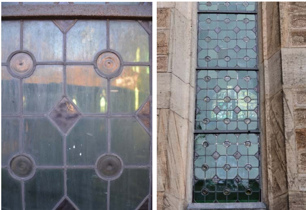
Links: Fenster sVII, Zustand vor der Restaurierung 2019 mit verschmutzten Glasoberflächen von außen; rechts: nach der Glasoberflächenreinigung von außen.
