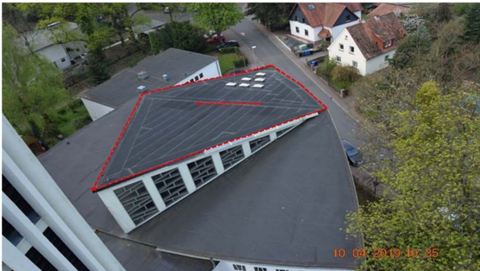
Die rote Umrandung markiert den zu sanierenden Dachbereich (vor Sanierung).
